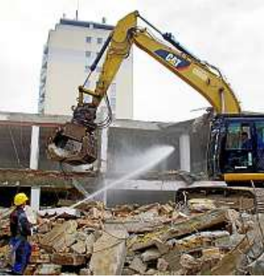
Staubwolken werden mit Wasser gelöscht: Unterhalb des Punkthochhauses an der Ecke Schützenhofstraße/Zitzmannstraße verschwindet eine frühere Einzelhandelsfläche. Foto: Thomas Baier
